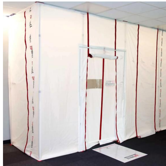
ISOLARE L'AREA DI LAVORO
