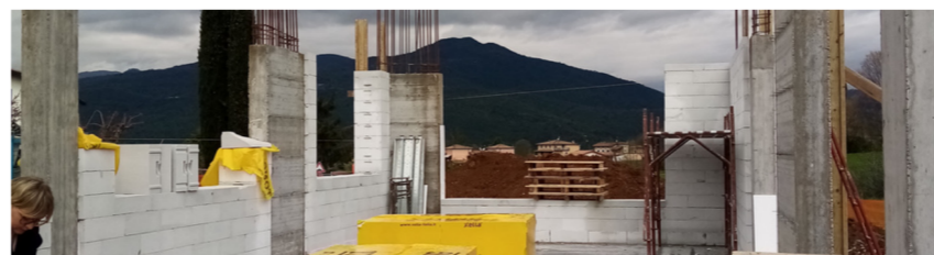
Venerdì 21 Aprile 2023 stato di avanzamento del cantiere
