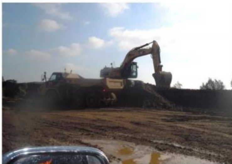
Fasi di lavoro nel cantiere della BreBeMi
