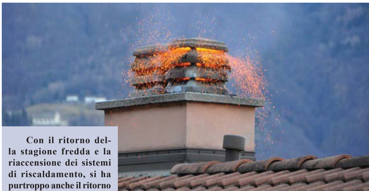
Incendio della fuliggine accumulata all'interno del camino
