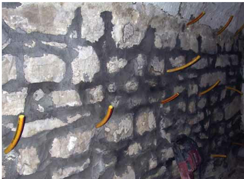
Intervento di iniezione semplice o armata
