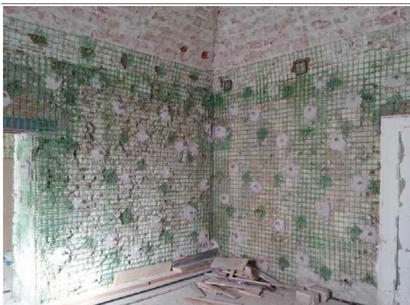
Intonaco armato con reti in fibra
